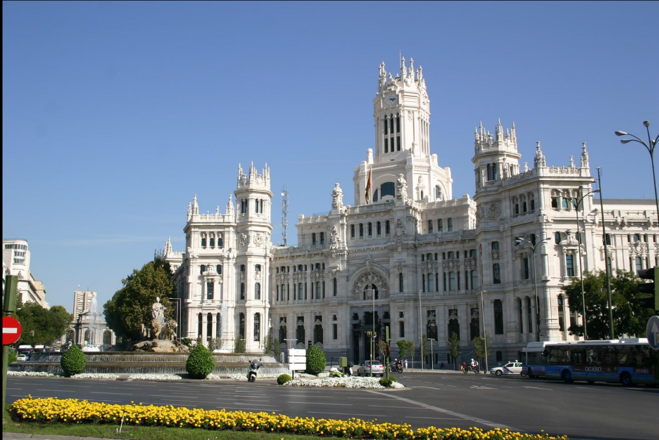
Ayuntamiento de Madrid, antiguo Palacio de la comunicaciones
